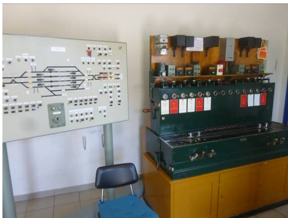
Obrázek 1: Řídicí přístroj elektromechanického zabezpečovacího zařízení (vpravo) a přídavný hradlový přístroj zajišťující vzájemné vazby mezi SZZ a TZZ směr Slavkov u Brna (vlevo) v ŽST Bučovice
